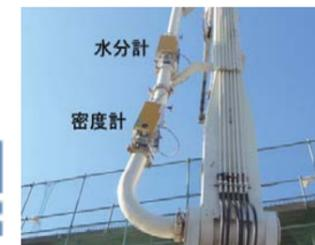
コンクリート水分量・密度計測器 COARA 連動
